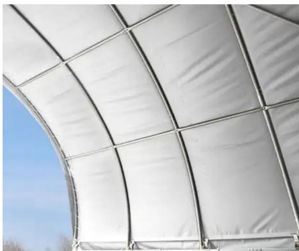
L'abribox est une solution de stockage stable montée entre deux containers 20 pieds. Le tunnel est composé d'une armature de tubes soudés en acier galvanisé protégés contre la corrosion.
